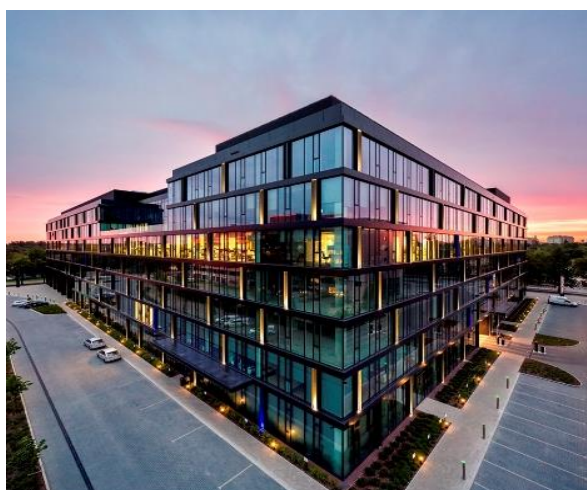
Konstruktorska Business Center – jedna z niewielu w całości wynajętych inwestycji biurowych w Warszawie
