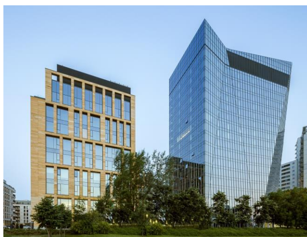
Gdański Business Center I to jedna z zaledwie pięciu warszawskich inwestycji posiadających certyfikat BREEAM Final na poziomie Excellent
