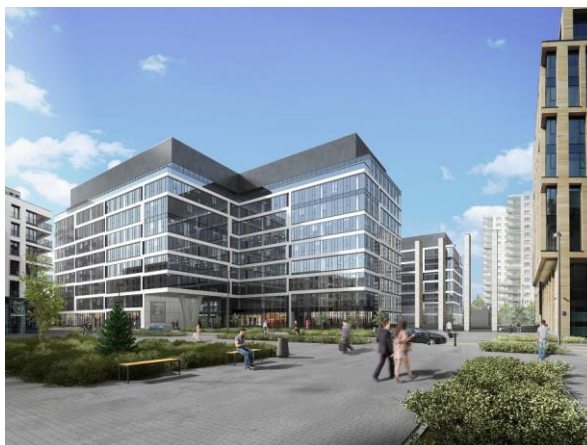
Budynek C kompleksu GBC II został oddany do użytku 4 miesiące przed planowanym terminem
